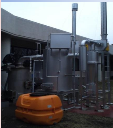
畜産系廃棄物専焼ボイラー
