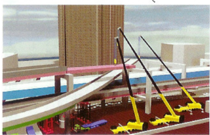
■橋桁の緊急撤去
