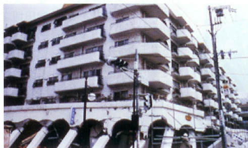
図1：阪神淡路大震災での建物崩壊被害
