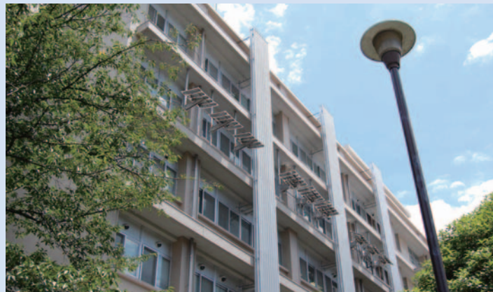
工学部1号館に装着したソーラーシェルフ
