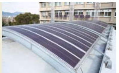
屋上に設置されているフィルム型ソーラーパネル
