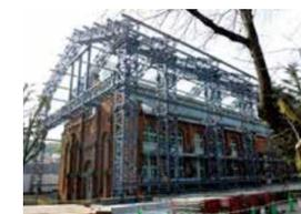
写真3：仮設鉄骨補強された工学部研究資料館
