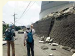
熊本地震 益城町の被災状況調査
