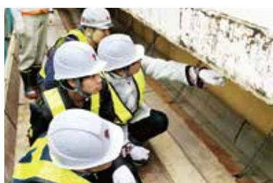
塩害により劣化した橋梁の調査
