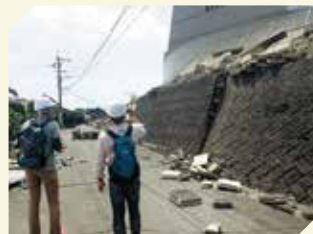
熊本地震 益城町の被災状況調査
