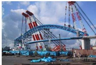
橋を吊り上げて架設(建設)しているところです。架設の際にも、材料や力学の知識が必要です。
