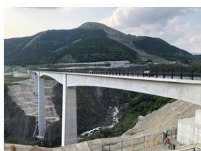
（社基-2）復興のシンボル・新阿蘇大橋もコンクリートでできています。
