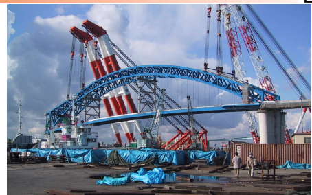
(社基-1) 橋を吊り上げて架設(建設)しているところです。架設の際にも、材料や力学の知識が必要です。
